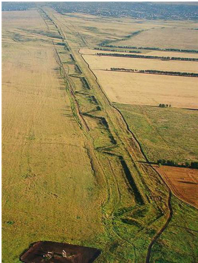
Рис. 2. Заволжская оборонительная линия. Высота вала около 3-х метров, длина около 200 километров (общая протяженность системы валов более 2 000 км)
